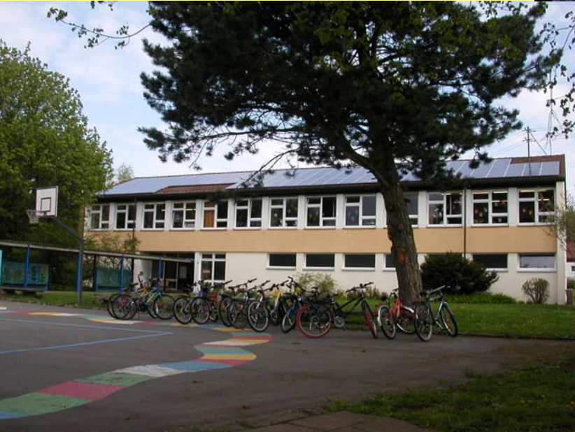
SonnenStrom-Bürgeranlage auf dem Dach der Grundschule Willmandingen
